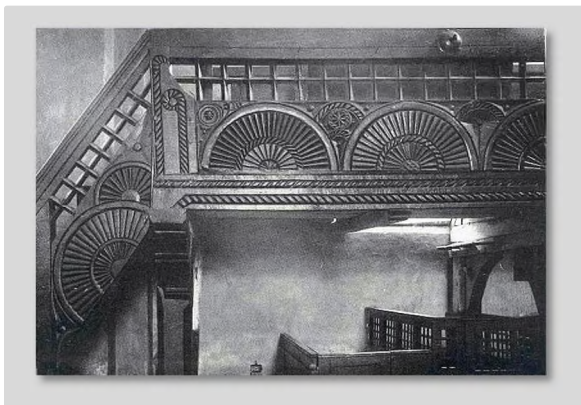
Abb. 16: Treppe zur Orgel-Empore. 1904
