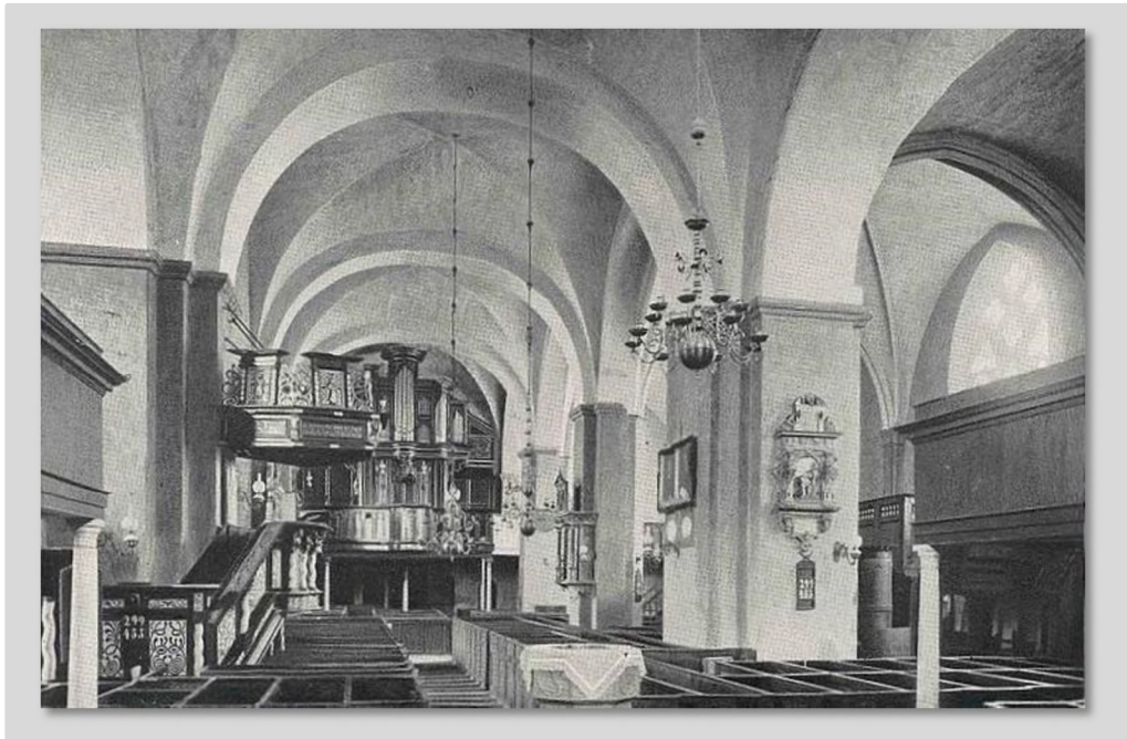
Abb. 15: Innenraum. Blick nach Westen. Zustand 1904
